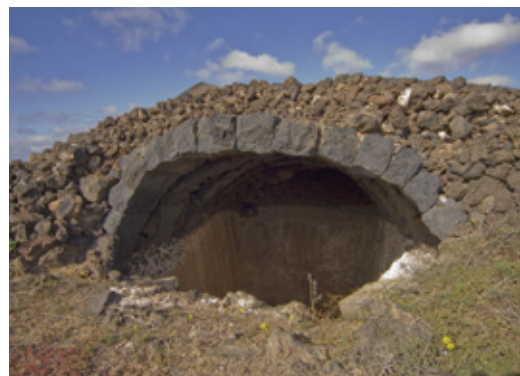
Detalle de los arcos que conforman la cubierta, abovedada, de un modelo de aljibe.
